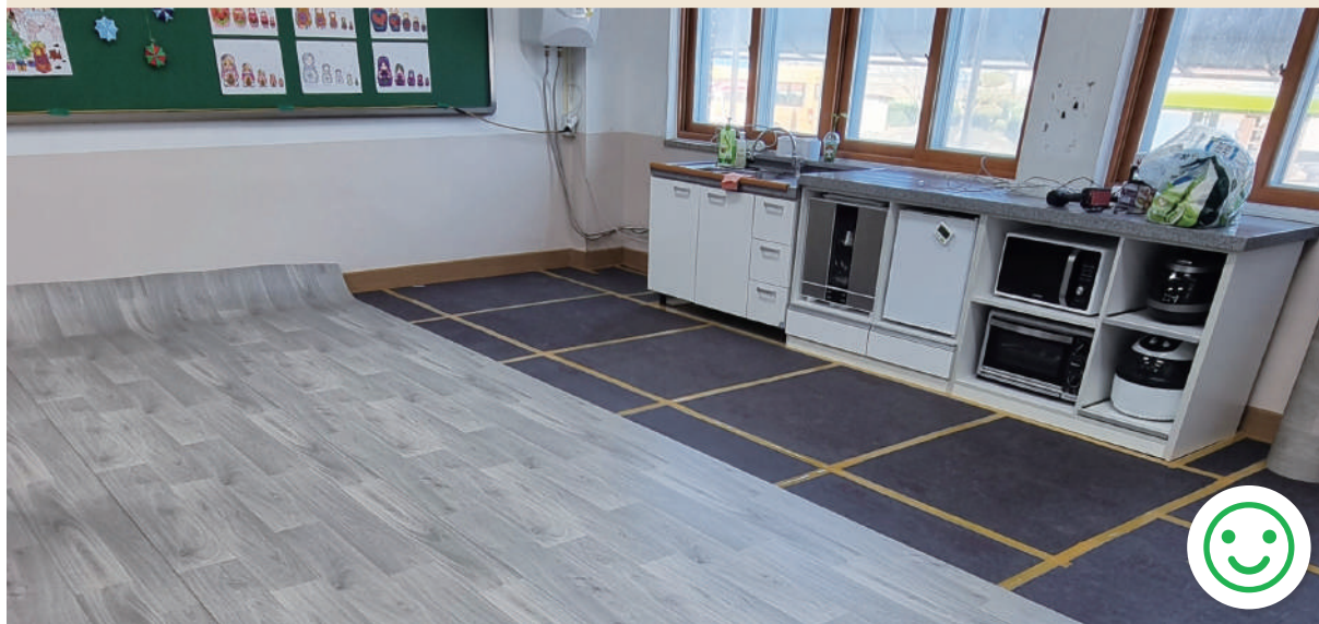
비접착식 모듈업 시공 시
