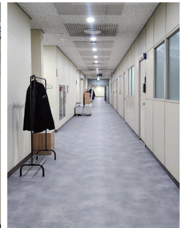
연세대학교 공학원(타일 위 시공)
