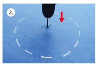
Bodenbelag etwa in der Mitte der zu reparierenden Fläche mit 4 mm Bohrer anbohren.
