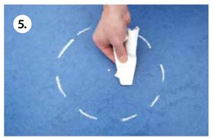
Überschüssigen Linoleum Doctor einfach mit dem Lappen entfernen. **Eurocol Linoleum Doctor** ist lösemittelfrei, wasserlöslich, hautverträglich und absolut ungefährlich für den Bodenbelag.
