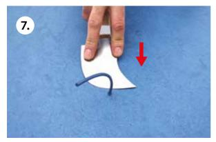
Farblich passenden Linoleum-Schmelzdraht erwärmen und in das Bohrloch einführen, überstehenden Schmelzdraht abstoßen.
