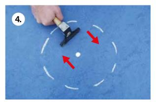
Mit dem Anreibehammer **Eurocol Linoleum Doctor** zunächst vom Bohrloch weg und anschließend zum Bohrloch hin gleichmäßig verteilen.
