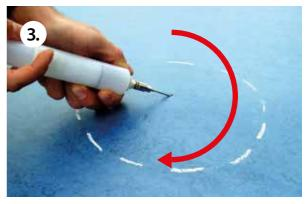
**Eurocol Linoleum Doctor** sparsam in die zu reparierende Fläche einspritzen. Während der Einspritzung wird die Injektionsspritze kreisförmig bewegt.
