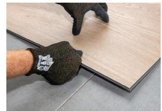
**Remarque :** essayez d'éviter les raccordements latéraux courts directement au-dessus ou à proximité des joints du support existant, comme par exemple sur des carreaux de carrelage.
