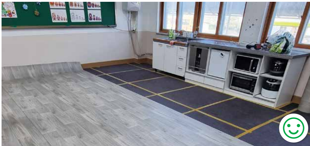
비접착식 모듈업 시공 시
