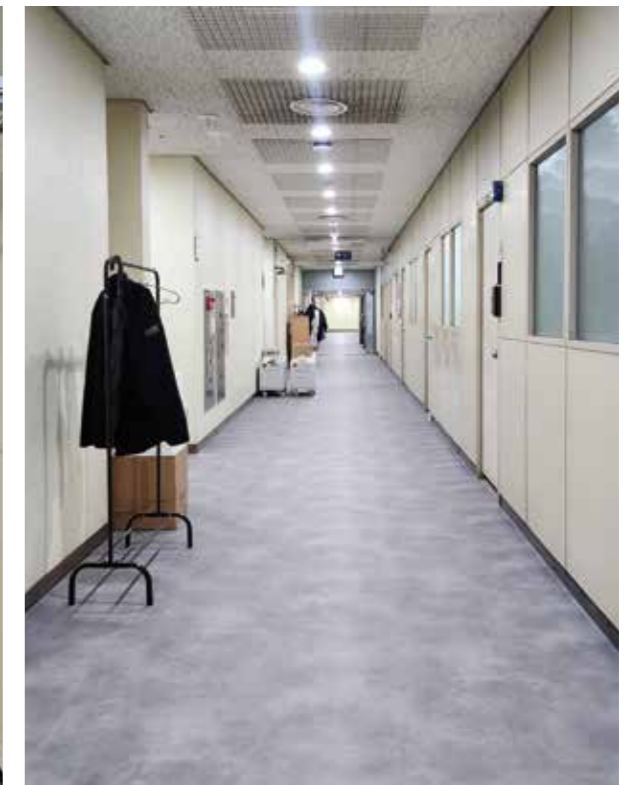
연세대학교 공학원(타일 위 시공)
