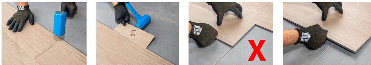
**Remarque:** essayez d'éviter les raccordements latéraux courts directement au-dessus ou à proximité des joints du support existant, comme par exemple sur des carreaux de carrelage.
