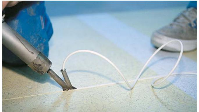
4. Das fachgerechte Abstoßen des Schweißdrahtes in noch warmem Zustand wird unter Verwendung des Mozart-Abstoßmessers und integriertem 0,7 mm-Schweißnahtschlitten (empfohlen) oder dem Viertelmondmesser mit Schweißnahtschlitten bis auf ca. 1 mm Überstand durchgeführt.
