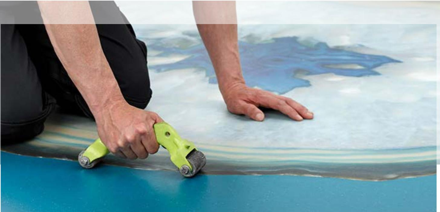
Eternal Vinylbeläge von Forbo können auf jeden verlegereifen Untergrund verlegt werden. Der Untergrund muss fest, tragfähig, dauer trocken und eben sein.
