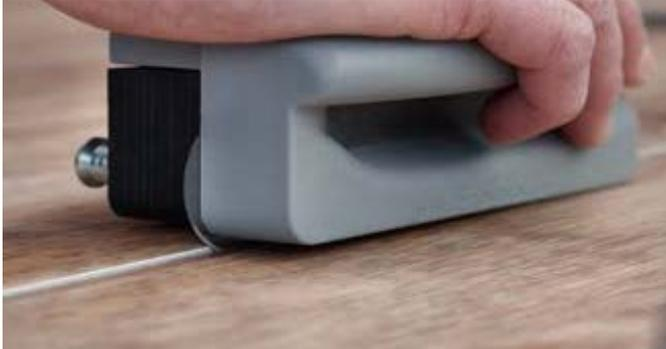
heitliches Verlegemuster ohne störende Unterbrechungen. Bei thermischer Verfugung sind die Bahnen so zu beschneiden, dass beiderseits die „Holzfuge“ entfernt ist und dadurch keine doppelte „Holzfuge“ entsteht, diese bildet dann der Schweißdraht. Nach dem Nahtschnitt werden die Bahnen ca. zur Hälfte in Längsrichtung zurückgeschlagen und der Klebstoffauftrag kann erfolgen.
