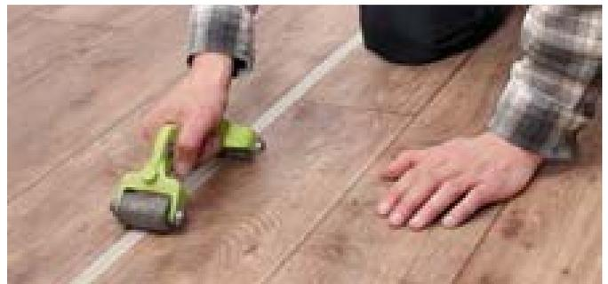
Dieses Klebeband wird nun exakt im Verlauf der Naht aufgetrennt. Dafür empfehlen wir ein Rollmesser zu benutzen. Danach sollte das Klebeband noch einmal angerieben werden. Es wird empfohlen, die Naht mit einem Heißluftgerät etwas vorzuwärmen damit die Nadel des Kaltschweiß-
