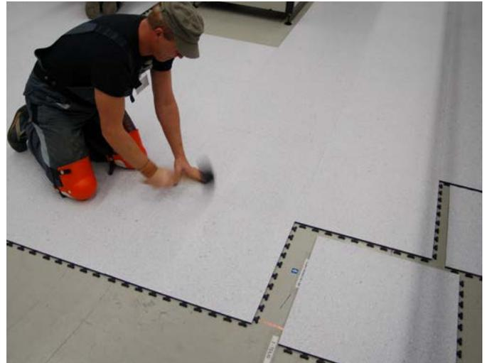
Mit Hilfe von zwei senkrecht zueinander stehenden Schnurschlägen markieren Sie an einer Ecke des Raumes zunächst den äußeren Rand der 2. Plattenreihe. Beginnen Sie dann die Platten von dieser Ecke aus einwärts zu verlegen und folgen Sie möglichst genau den Schnurschlägen.
