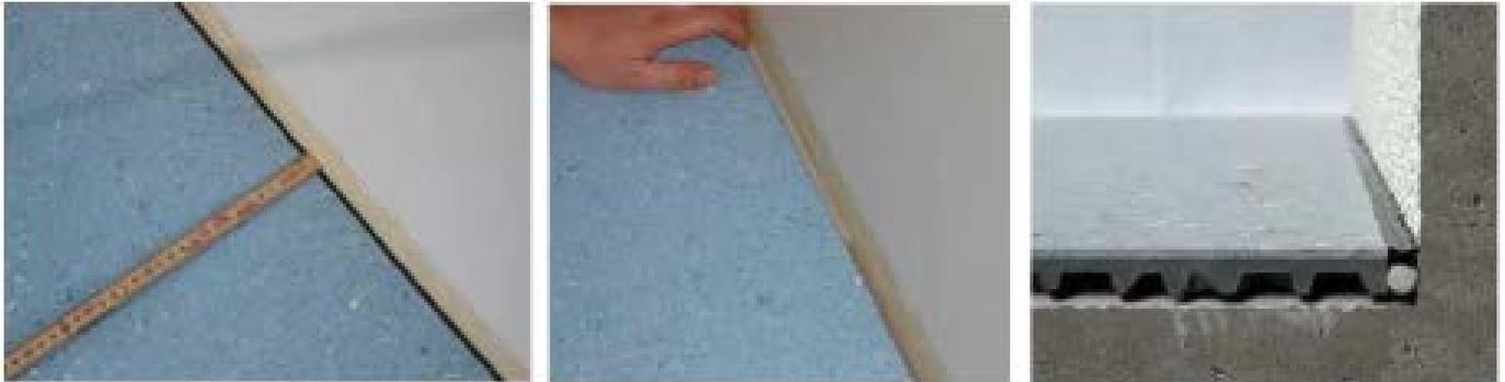
Mit Colorex Plus ist es möglich, wasserdichte und hygienische Hohlkehlsöckel mit verschweißten Innen- und Außenecken aus Bodenbelagsmaterial auszubilden. Diese Wandanschlussvariante ist speziell für hygienische Bereiche oder für WHG 19 taugliche Anwendungen gedacht.
