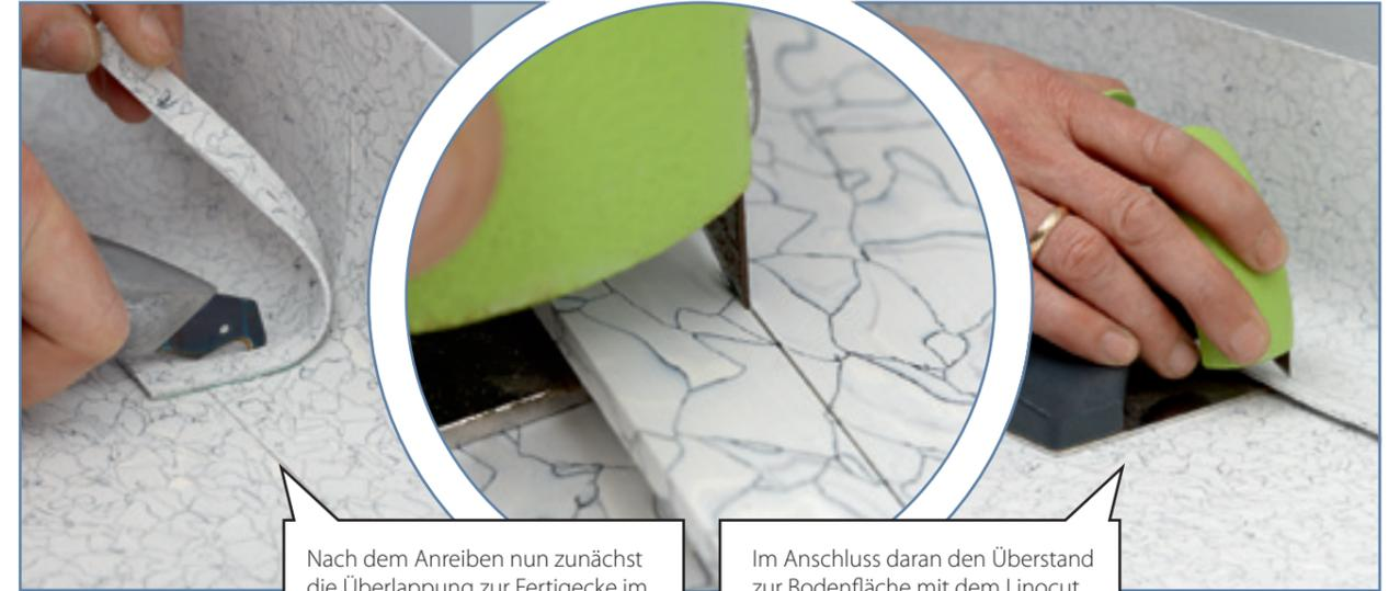
Nach dem Anreiben nun zunächst die Überlappung zur Fertigecke im Unterkantenschnitt schneiden.
