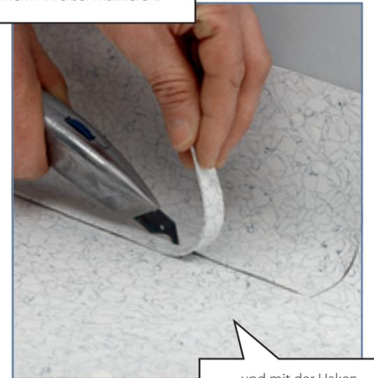
...und mit der Hakenklinge unterschneiden.
