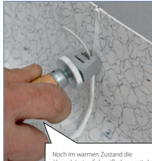
Noch im warmen Zustand die überschüssige Schweißschnur mit dem Fugenputzer (Trapezklinge) entfernen.
