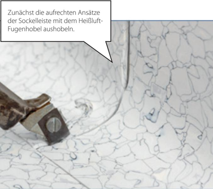
Zunächst die aufrechten Ansätze der Sockelleiste mit dem Heißluft-Fugenhobel aushobeln.
