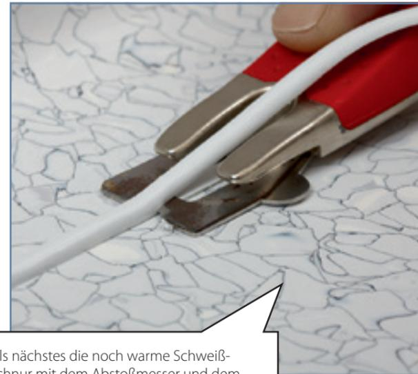
Als nächstes die noch warme Schweißschnur mit dem Abstoßmesser und dem Schweißnahtschlitten zur Hälfte abstoßen...
