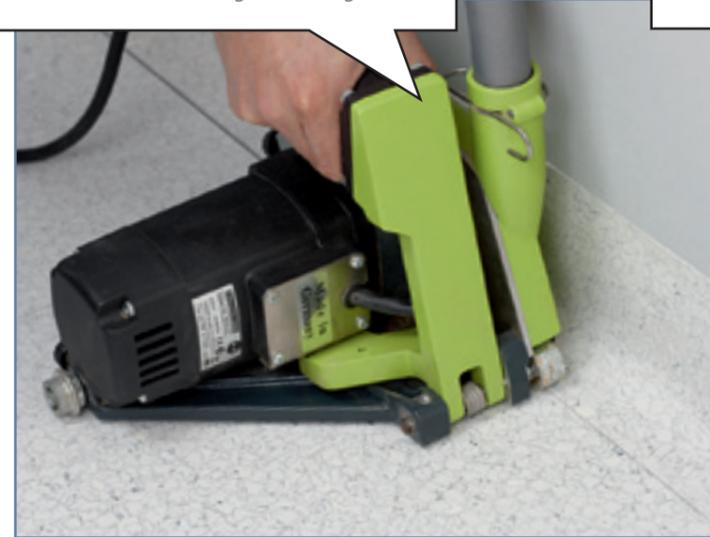
Danach die Schweißschnur mit der Schnellschweißdüse bei ca. 400 C° einbringen. Auch hier empfehlen wir den Ansatz zum Belag mit einem Kreppband zu schützen.
