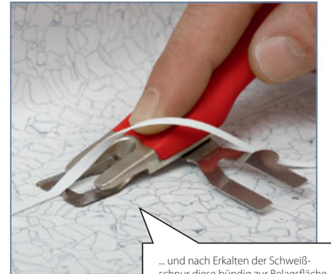
... und nach Erkalten der Schweißschnur diese bündig zur Belagsfläche mit dem Abstoßmesser abstoßen.
