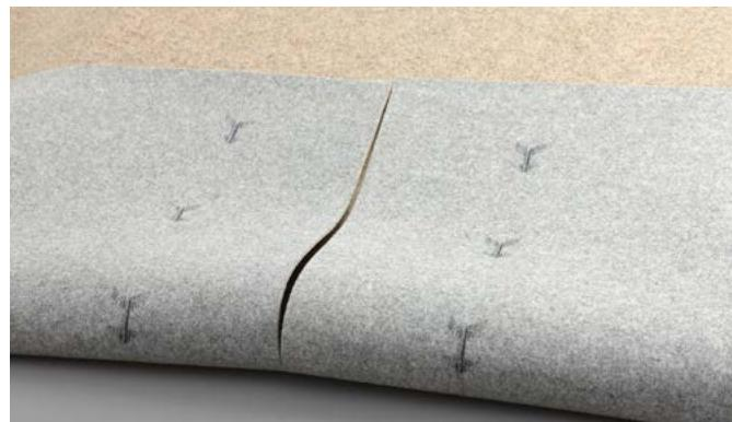
Vor der Verklebung der ersten Bahn ist im Nahtbereich die Werkskante zu beschneiden. Die Kante sollte ca. 1,5 - 2,0 cm beschnitten werden. Bei Markant Graphic City ist beim Kanten-/Nahtschnitt auf Breitenrapport zu achten. Wir empfehlen hierfür den Einsatz des Forbo Trimmers oder vergleichbarer Werkzeuge.
