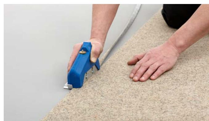
Die zweite Bahn wird im Nahtbereich ca. 2 cm überlappend ausgerollt und nach der Verklebung dicht an die untenliegende Bahn geschnitten. Hier kann ein Linocut mit höherer Anschlagkante verwendet werden.
