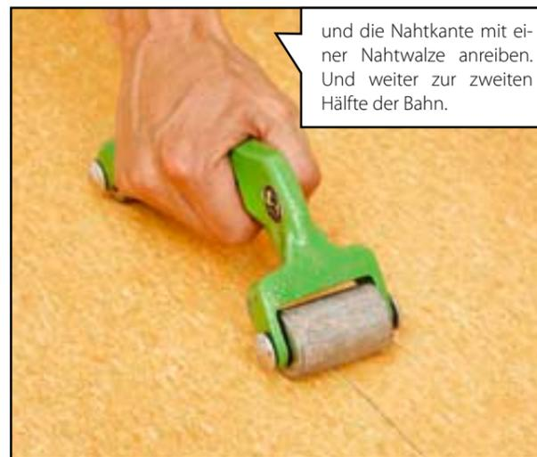
und die Nahtkante mit einer Nahtwalze anreiben. Und weiter zur zweiten Hälfte der Bahn.
