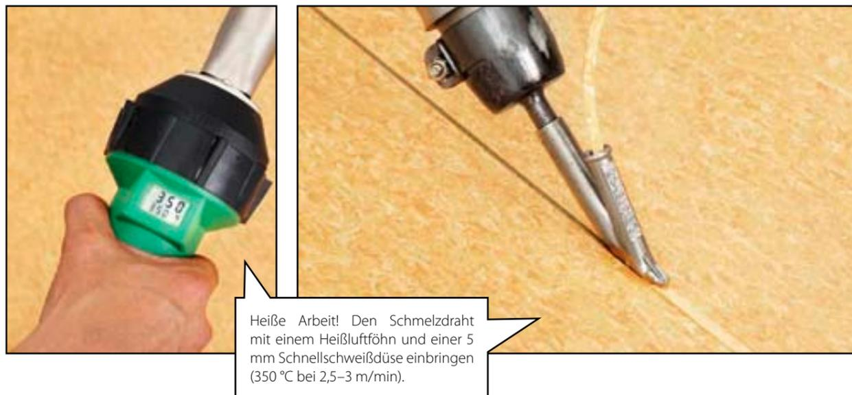
Noch im warmen Zustand den Schmelzdraht das erste Mal mithilfe des Schweißnahtschlittens abstoßen.
