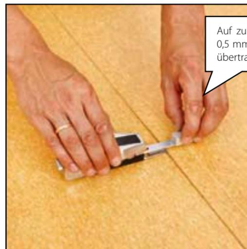
Auf zur perfekten Nahtkante: Zuerst 0,5 mm Luftschnitt mit dem Anreißer übertragen,
