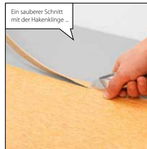
... und das Linoleum bis zur Markierung auf dem Boden zurückschieben. Fertig!
