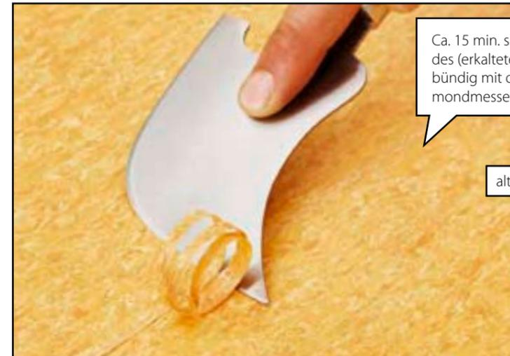
Ca. 15 min. später: Die Naht des (erkalteten) Drahtes bündig mit dem Viertelmondmesser abstoßen.
