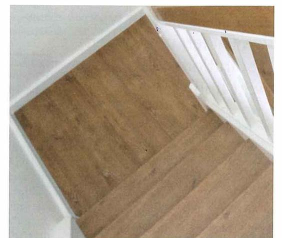
Das System umfasst verschiedene, für die Montage optimierte Längen- und Breitenformate. Das jeweilige Element wird mit einer Stich- oder Kreissäge zugeschnitten. Insbesondere beim Zuschnitt gezogener Stufen ist eine „Treppenschmiege“ hilfreich (siehe Kasten)
