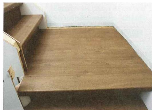
Von oben nach unten arbeiten. Zum Begehen während der Verlegung kann im ersten Arbeitsschritt jede zweite Stufe ausgelassen werden
