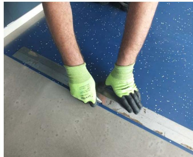
Beim Vorschneiden der unteren Bahn dient die beschnittenen Nahtkante der oberen Bahn als Führung. Durch Einsatz
