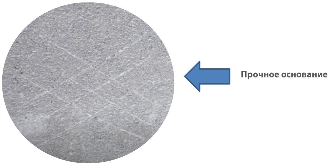
**СТАБИЛЬНОСТЬ И ЦЕЛОСТНОСТЬ основания** также напрямую влияет на качество выравнивающей смеси и ее адгезию с последующим клеевым слоем.
