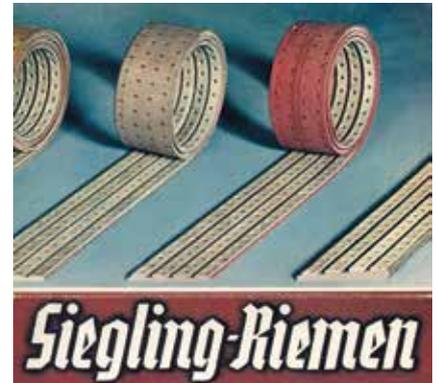
そして1940年代初頭にはポリアミドとクローム革による多層式の平ベルトが開発され、これが技術的マイルストーンとなりました。ここでは、伸張性の高いポリアミドベルトが心体としての機能を果たす一方、薄いクローム革層が走行面として機能しました。このベルト構造は両方の材料のメリットを1本のベルトにまとめることになり、様々な材料を使用して現在にいたるまで活躍しています。98%以上という高い伝動効率を達成し、従来のベルト駆動およびチェーン駆動をはるかに超えるエネルギー効率が実現されました。1943年、この技術は特許を取得し、「Extremultus」の名のもと市場に導入され、1940年代の終わり以降には世界中で販売されることになりました。
