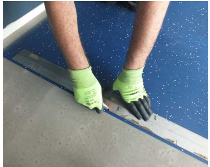
Beim Vorschneiden der unteren Bahn dient die beschnittene Nahtkante der oberen Bahn als Führung. Durch Einsatz
