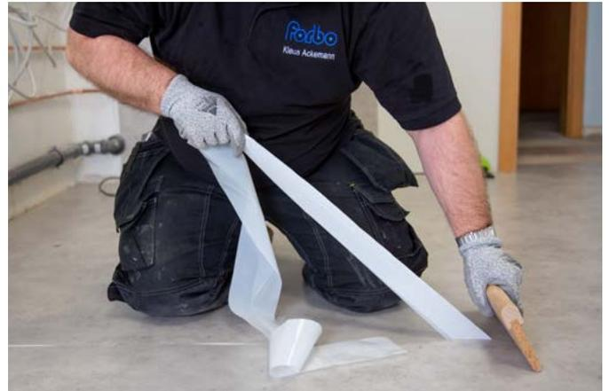
Nun wird die Naht geschnitten. Hierzu wird mit einem Linocut (oder vergleichbar) der untere Kantenverlauf auf die darüber liegende Bahn übertragen und anschließend mit der Hakenklinge durchtrennt. Durch die Verwendung der Hakenklinge wird ein Durchtrennen des Nahtbandes verhindert.
