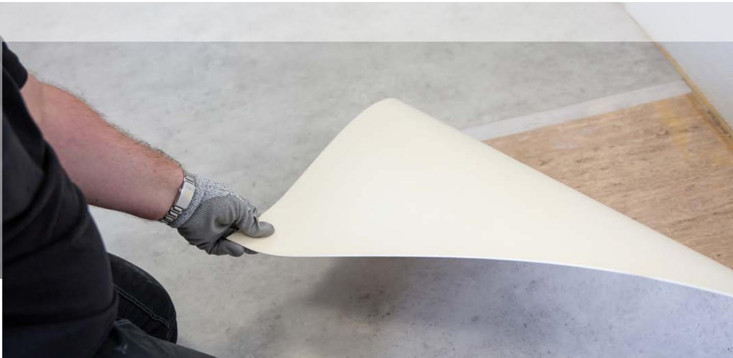
Modul'up Vinylbeläge von Forbo können auf jeden verlegereifen Untergrund verlegt werden. Der Untergrund muss fest, tragfähig, dauer trocken und eben sein.
