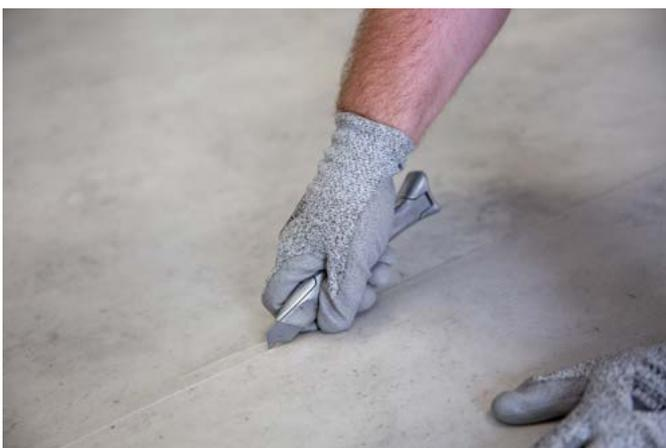
Bei den Holzoptiken sind die Bahnen so zu beschneiden, dass beiderseits die „Holzfuge“ entfernt ist und dadurch keine doppelte „Holzfuge“ entsteht, diese bildet dann der Schweißdraht.
