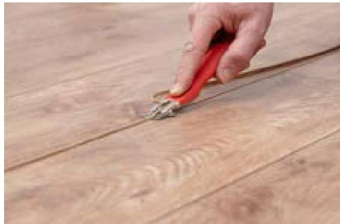
4. Nach vollständigem Erkalten des Schweißdrahtes wird der Überstand sorgfältig mit dem Mozart-Abstoßmesser ohne Schweißnahtschlitten (empfohlen) oder einem scharfen Viertelmondmesser ohne Schweißnahtschlitten belagsbündig abgestoßen.
