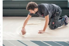
6. Die Verlegung des „Flotex“-Belags erfolgt in das halbnaasse Klebstoffbett - die Klebstoffriefe muss verdrückt werden.
