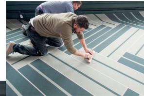
7. Unmittelbar nach dem Einlegen werden die Nähte angerieben und die Flächen angerollt.
