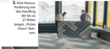
3. Eine Herausforderung war das Handling der bis zu 27 Meter langen „Flotex Vision“-Bahnen.
