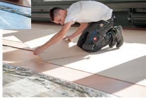
2. Darauf erfolgte das Verlegen des MDF-Unterbodensystems „QuickFit“ in zwei Lagen.
