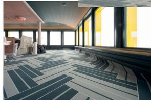
4. Die werkseitig beschneitten Produktionskanten können musterpassend aneinandergelagt werden.
