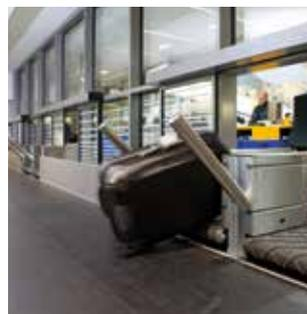
Problemloses seitliches Aufschieben des Transportgutes durch gute Planlage und glatte Oberflächen der Bänder.
