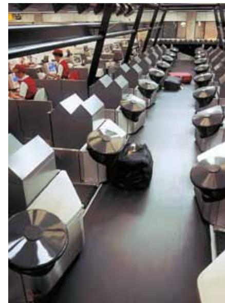
Bandă colectoare în zona de Check-In pe un aeroport. O poziție foarte plană a tipului de bandă utilizat permite, chiar și la benzi cu lățime mai mare, încărcarea fără dificultate a bagajelor prin lateral. Execuția de tip „greu inflamabil” este o exigență absolută pe aeroporturile moderne.
