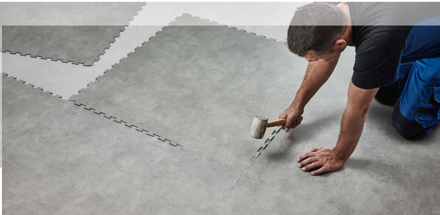
Allura Puzzle von Forbo kann auf jeden verlegereifen Untergrund verlegt werden. Der Untergrund muss fest, tragfähig, dauertrocken und eben sein.
