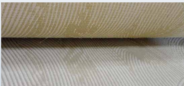
Bij te lange open tijd blijven er 'waterkanalen' onder het linoleum aanwezig.
