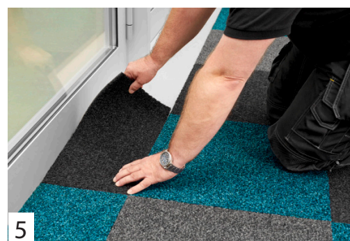
5 Die untenliegende Fliese wird mit der Trapezklinge angeschnitten und nach Entfernen der oberen Fliese durchtrennt.
