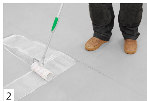
2 Eine Spezialfixierung für Textilfliesen, beispielsweise 542 Eurofix Tack Plus von Eurocol, wird aufgetragen.
