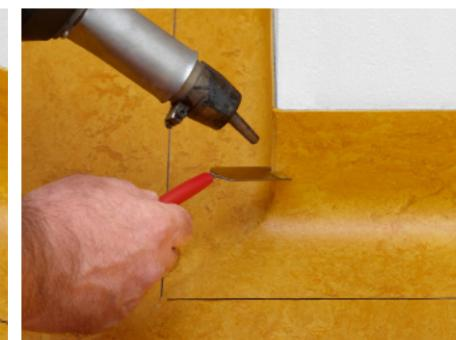
8. Durch Nacharbeiten mit Handschweißgerät und keilförmig eingekerbtem Spachtel...
