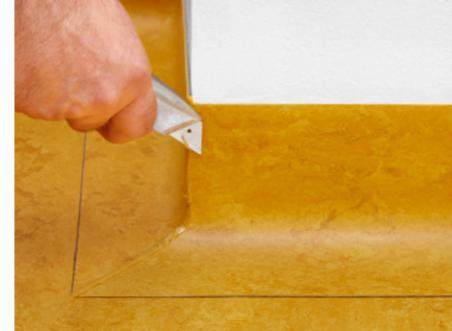
6. Überstehender Schmelzdraht wird in der Vertikalen mit dem Messer...
