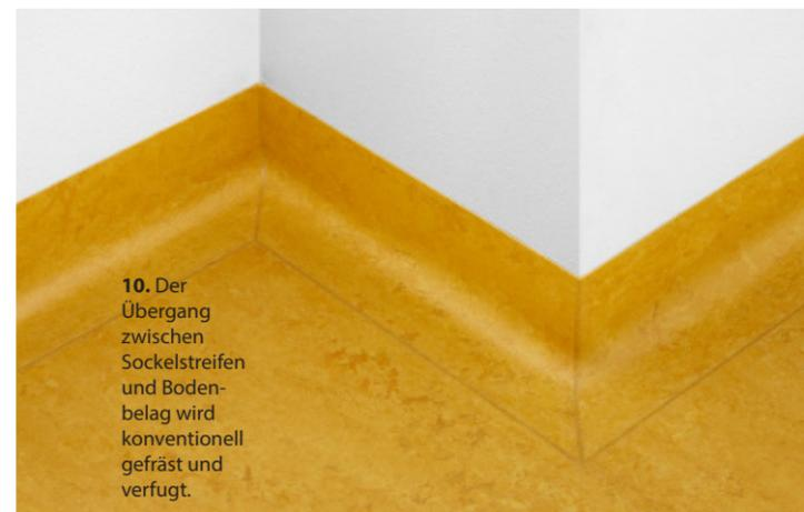
10. Der Übergang zwischen Sockelstreifen und Bodenbelag wird konventionell gefräst und verfugt.
