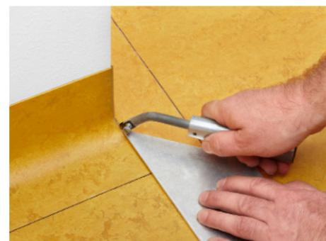
4. ... und einem Hand-Fugenhobel, so dass eine gleichmäßig halbrunde Fuge ausgebildet wird.
