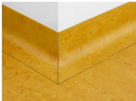
3. Die Fugenausbildung der Ecken erfolgt mit Fingerspitzengefühl mit einem Messer...
