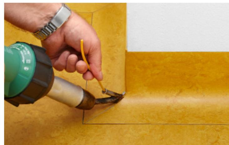
5. Die Gehrungsschnitte werden mit dem Handschweißgerät bei 350 Grad verfugt.
