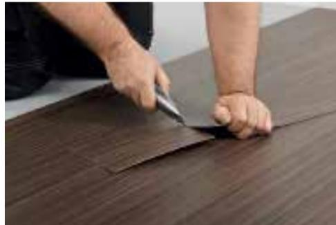
3. Im Anschluss daran die angerissene Planke mit der Hakenklinge durchtrennen.
