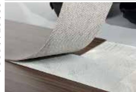
9. Bei einer zu spät eingelegten oder nicht ordnungsgemäß angewalzten Planke, ist eine einwandfreie Klebung nicht gewährleistet. Prüfungen während der Verlegung sind unerlässlich.
