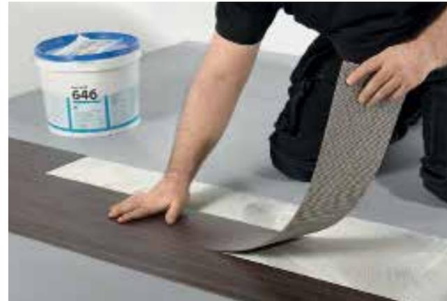
4. Die zugeschnittene Planke ohne zu stauchen an der Wand passgenau einlegen.
