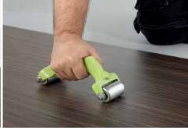
6. Nach dem Einlegen ins nasse Klebstoffbett werden die Planken mit der Handwalze und im Nachgang mit einer ca. 70 kg Walze angewalzt.
