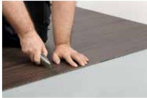
2. Beim Wandanschluss die einzupassende Planke deckungsgleich auf die letzte Planke legen, eine neue bündig an die Wand legen und den Kopfstoß anreißen.
