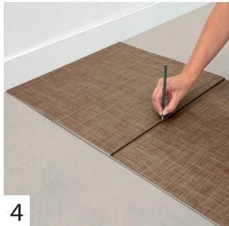
Zum exakten Anarbeiten an die Wand wird der Verlauf auf die Planke übertragen. Dazu bietet sich die Parallelverschiebung oder die Verwendung einer Schmiege an.
