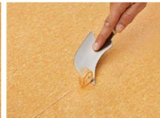
dass sie dem Führungsrad in der Naht folgt, und die gewünschte Fuge mittig zwischen den beiden Nahtkanten entsteht.
