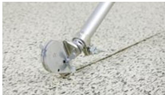
Das Anreißen, der Nahtschliff und das Verfügen lassen sich mit Spezialwerkzeug im Stehen ausführen. Die richtige Technik wird Forbo Flooring in speziellen Verlegeschulungen vermitteln.
