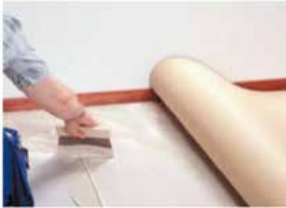
Lijm aanbrengen
