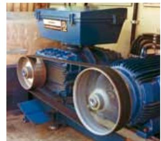
Las correas de transmisión Siegling Extremultus superan cualquier comparación con otros elementos de transmisión gracias a su eficiencia ( $\geq 98\%$ ), la elevada precisión de su marcha (sin fluctuaciones) y la sencillez de su manejo.
