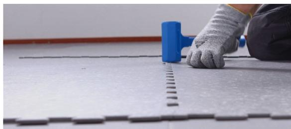
Il convient d'adapter la force de martellement de manière à assembler les dalles parfaitement sans abimer le support ou les joints des dalles.
