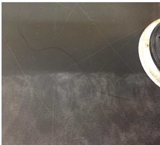
Kontrollera att skadorna är helt bortslipade.
