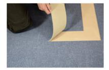
Appliquez une nouvelle couche de colle acrylique. Posez la bande Artline dans la colle après le temps d'attente indiqué par le fabricant de la colle et à l'aide d'une planche à maroufler, pressez fermement la bande dans la colle (voir ci-dessous).
