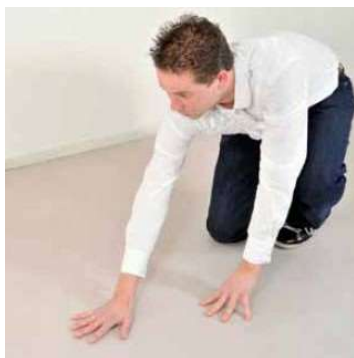
1. Pour la pose, le support doit être sec, solide, porteur et plan. Le cas échéant, les irrégularités doivent être corrigées
