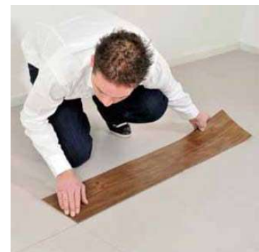
3. Insérez la lame de vinyle dans le lit de colle et massez la lame à partir du centre vers l'extérieur pour éliminer les bulles d'air
