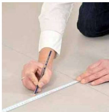
2. Déterminez le centre de la pièce en traçant deux lignes perpendiculaires.
