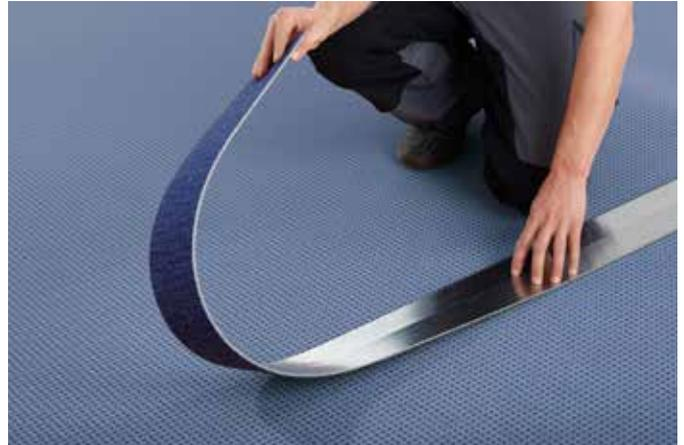
Die Bahnen werden in Längsrichtung umgeschlagen und das Nahtband wird mit Hilfe eines Korkbretts im Nahtbereich aufgebracht.
