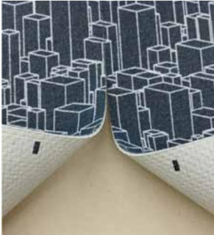
Nähte werden mit 100 mm breitem einseitigem Nahtband befestigt. Die Anschnitte an Wänden, aufgehenden Bauteilen etc. werden grob vorgeschritten.
