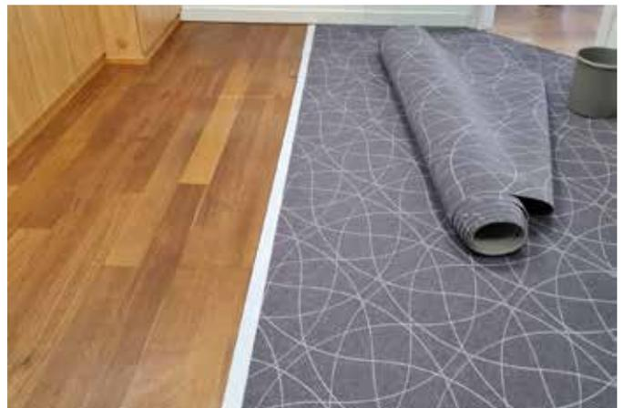
Nun wird der Belag im Bereich der Nähte angehoben, um die Schutzfolie des Nahtbandes zu entfernen. Hiernach wird der Belag mit Hilfe des Korkbretts angerieben.
