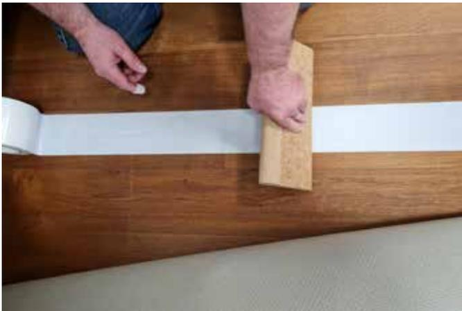
Zum Schneiden von Anschlüssen an Säulen o. ä. wird empfohlen, auf die zu verwendende Schiene rückseitig Flotex-Belag mit Klebeband aufzukleben, damit ein Verrutschen der Schiene verhindert wird.
