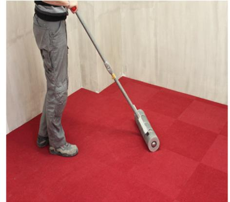
**6** Dans le cas d'une pose collée en plein, maroufler l'ensemble à l'aide d'un cylindre marouffleur et attendre au minimum 48 heures avant l'ouverture au trafic et 72 heures avant l'agencement des locaux.
