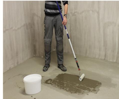
**3** Etendre le produit de maintien (colle poissante) au rouleau ou appliquer la colle à la spatule (dans le cas d'une pose collée en plein). Respecter le temps de gommage et le temps ouvert. (Voir conditions du fabricant).
