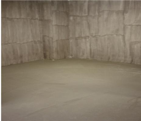
**1** Les supports destinés à recevoir les revêtements de sol doivent être propres, sains, secs, solides, plans et normalement absorbants conformément au DTU en vigueur. Les dalles devront être stockées à plat dans le local 48 heures précédant la pose à
