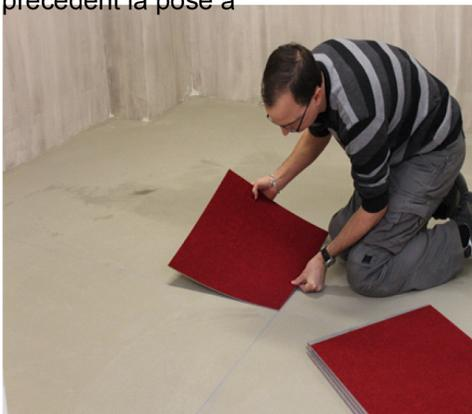
**4** Mettre en place la 1ère dalle en suivant les axes de pose. Poser et maroufler, joints bien serrés, les dalles entières suivantes, sur l'ensemble de la surface. En fonction des dessins, la pose peut être contrariée à 90° ou monolithique.
