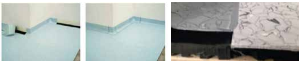
zgrzew na połączeniu kształtownika oraz płytki
