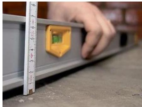
Необходимая толщина слоя заливки - это максимальный показатель отклонения от нижнего края рейки до крайней точки углубления, который определяется по результатам всех выполненных замеров с помощью правила.
