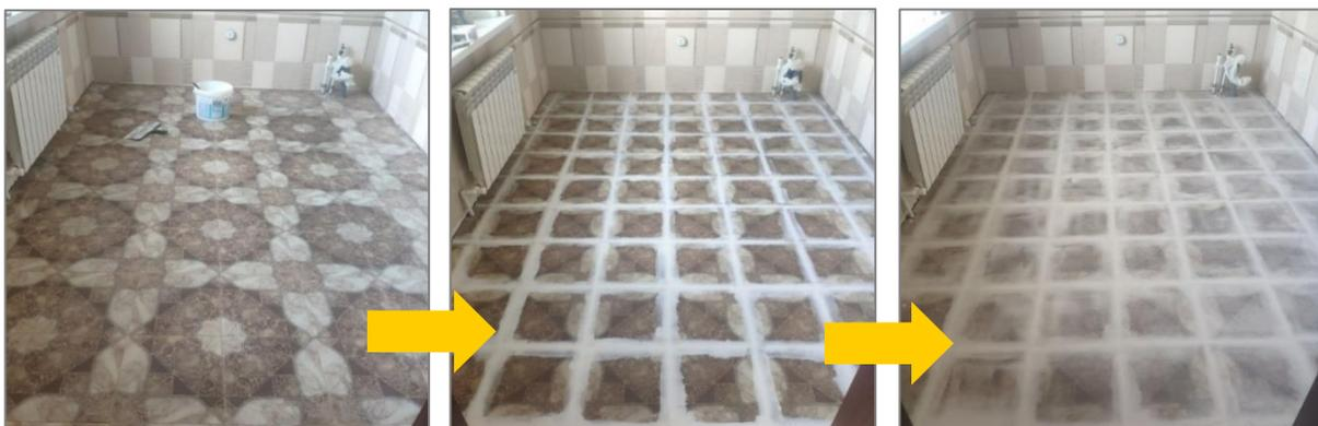
Для создания более толстого слоя шпатлевку также следует наносить в несколько подходов толщиной до 1 мм с промежуточным высыханием (2-4 часа) и шлифовкой.
