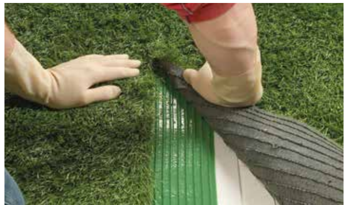
› Anpassen des Rasens durch das Nahtband
