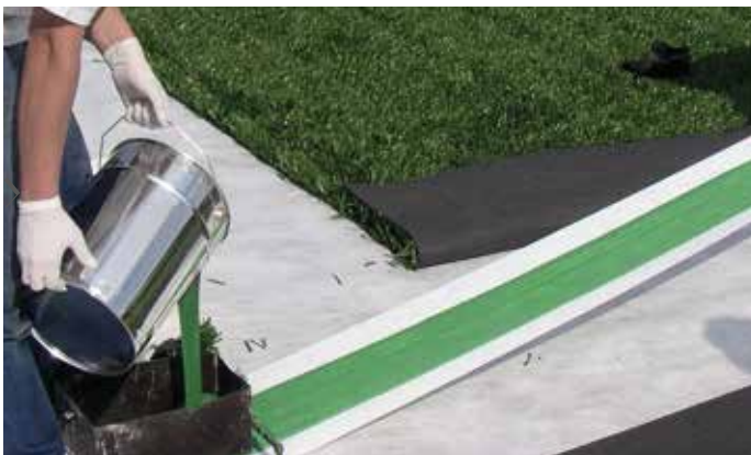
› Klebstoff auf Nahtband auftragen
