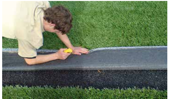
› Schneiden der Fugenkanten
