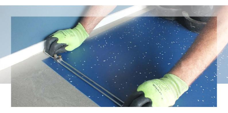
Sphera Vinylbeläge von Forbo können auf jeden verlegereifen Untergrund verlegt werden. Der Untergrund muss fest, tragfähig, dauertrocken und eben sein.
