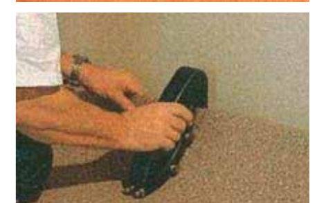
フォルボ・スクライバーによるシート末端けがき
