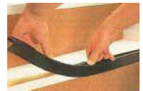
ディスク&ルーラー、鉛筆、型紙を使って階段に施工
