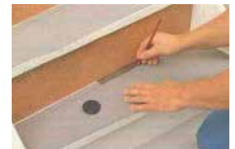
ディスク&ルーラー、鉛筆、型紙を使って階段に施工
