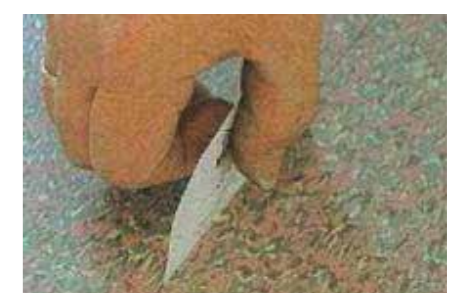
フォルボ・スクライバーによるシート末端けがき
