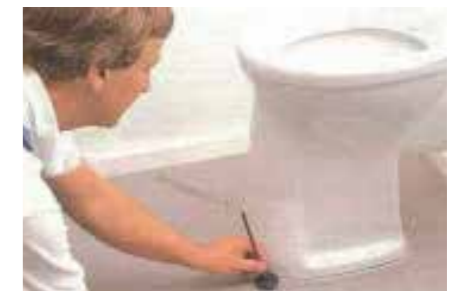
ディスク&ルーラー、鉛筆、型紙を使ってトイレに施工
