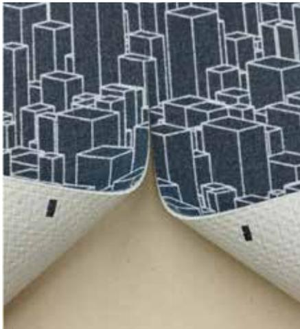
Les joints sont fixés avec la bande de jonction simple face de 100 mm de large. les raccords aux murs, aux composants montants, etc. sont prédécoupés grossièrement.
