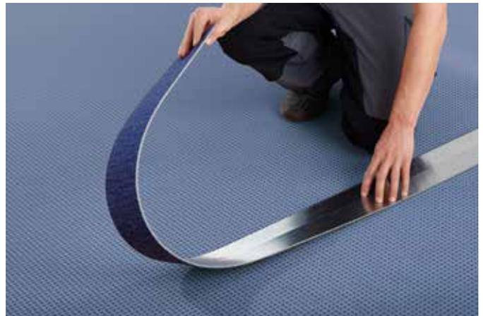
Les lés sont rabattus en arrière dans le sens de la longueur et la bande de jonction est appliquée au niveau du joint à l'aide d'une planche de liège.
