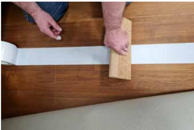
Pour la découpe de raccords sur les colonnes ou autres raccords, il est recommandé de coller sur le profilé à utiliser au dos le revêtement Flotex avec une bande adhésive afin d’empêcher que le profilé ne glisse.
