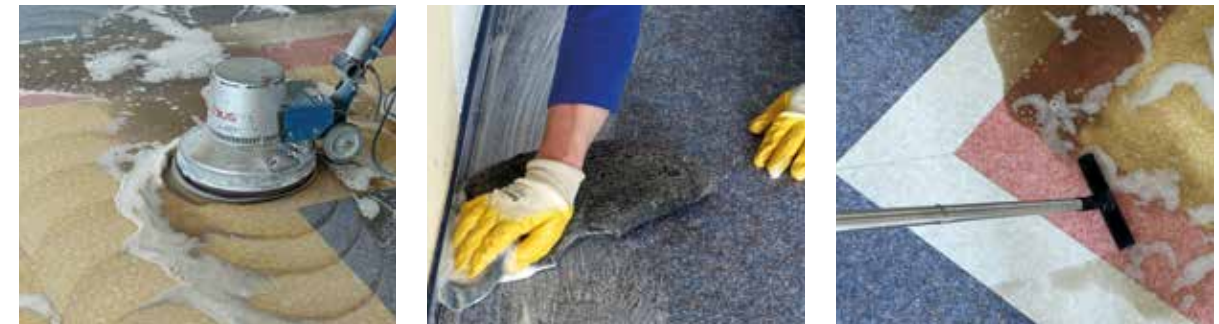
Nassschleifen und Grundreinigen mit dem Eurocol Repair Pad in Kombination mit der 891 Euroclean Basic (alkaline) . Wet sanding and base cleaning with Eurocol repair pad in combination with 891 Euroclean Basic (alkaline) .
