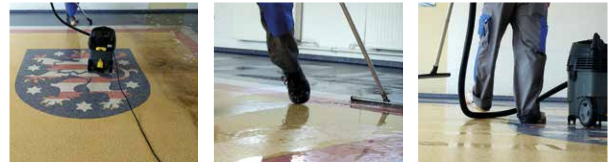
Entfernung des Schmutzwassers und ausreichende Neutralisation des Bodenbelages. Komplette Abtrocknung des Bodenbelags gewährleisten. Removal of mopping water. Neutralize the alkaline content on floor coverings with clear water. Allow the floor covering get dry.
