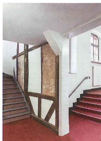
**Bild 6.** Behutsam eingefügte Stahlstützen stabilisieren heute das Gebäude und sichern die Tragfähigkeit
