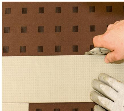
**4** Positionner les bandes à incruster sur le lé "face contre face" afin de les maintenir.
