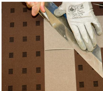
**7** Réaliser la découpe des angles avec une règle et un cutter lame droite.
