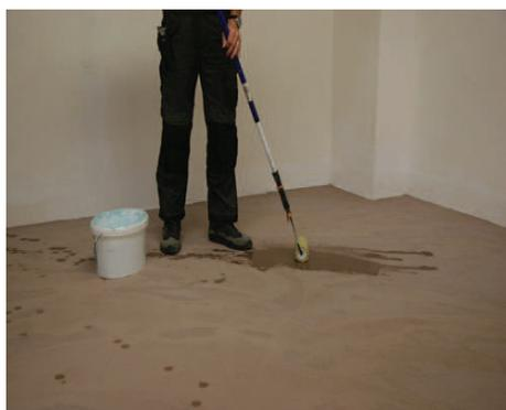
**3** Étendre le produit de maintien (colle poissante) au rouleau. Respecter le temps de gommage et le temps ouvert (voir conditions du fabricant).
