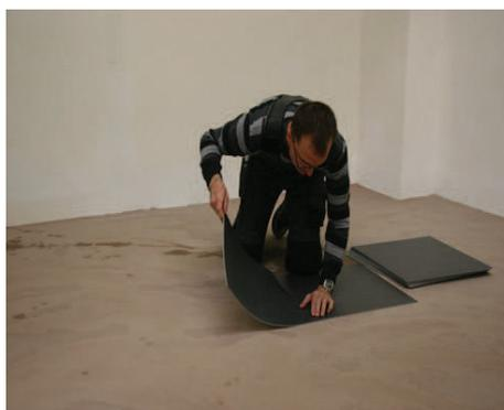
**4** Mettre en place la première dalle en suivant les axes de pose. Poser et maroufler, joints bien serrés, les dalles entières suivantes, sur l'ensemble de la surface. En fonction des dessins, la pose peut être contrariée à  $90^{\circ}$  ou monolithique.
