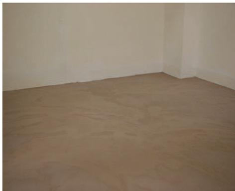
**1** Les supports destinés à recevoir les revêtements de sol doivent être propres, sains, secs, solides, plans et normalement absorbants, conformément au NF DTU en vigueur. Les dalles devront être stockées à plat dans le local, 48 heures précédant la pose, à une température  $\geq 15^{\circ}\text{C}$ . En cas de doute sur la préparation de support, vous rapprocher du fabricant.
