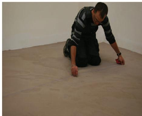
**2** La position des axes pour l'implantation des dalles doit être telle que la dimension des coupes en rive soit équilibrée et partout suffisante pour permettre un bon collage (1/2 dalle au minimum).
