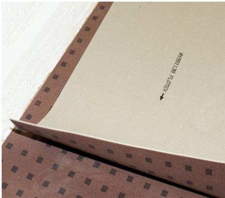
**1** Réaliser au sol une implantation des bandes et des lés.
