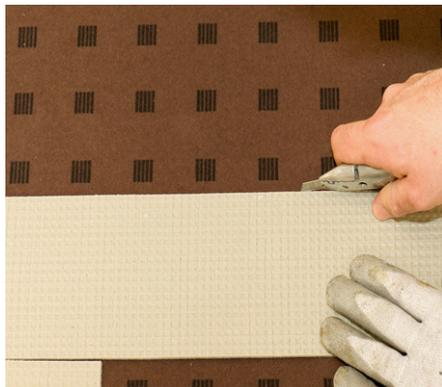
**4** Positionner les bandes à incruster sur le lé "face contre face" afin de les maintenir.
