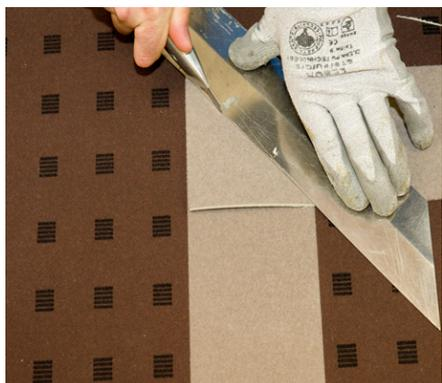
**7** Réaliser la découpe des angles avec une règle et un cutter lame droite.
