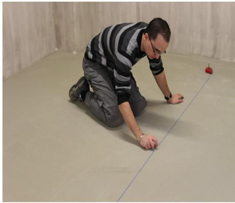
**2** La position des axes pour l'implantation des dalles doit être telle que la dimension des coupes en rive soit équilibrée et partout suffisante pour permettre un bon collage (1/2 dalle au minimum).
