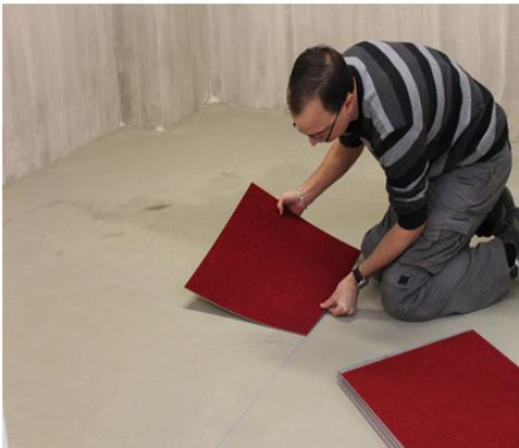
**4** Mettre en place la 1<sup>ère</sup> dalle en suivant les axes de pose. Poser et maroufler, joints bien serrés, les dalles entières suivantes, sur l'ensemble de la surface. En fonction des dessins, la pose peut être contrariée à  $90^{\circ}$  ou monolithique.
