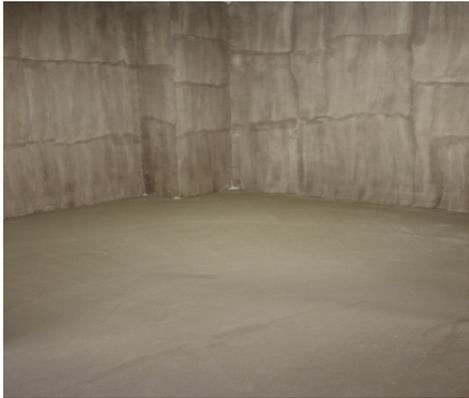
**1** Les supports destinés à recevoir les revêtements de sol doivent être propres, sains, secs, solides, plans et normalement absorbants conformément au DTU en vigueur. Les dalles devront être stockées à plat dans le local 48 heures précédant la pose à une température  $\geq 15^{\circ}\text{C}$ . en cas de doute sur la préparation du support, vous rapprocher du fabricant.
