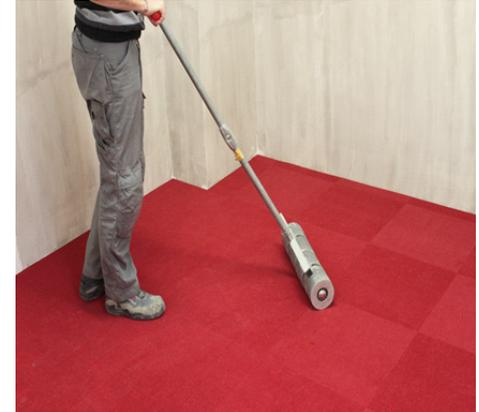
**6** Dans le cas d'une pose collée en plein, maroufler l'ensemble à l'aide d'un cylindre marouffeur et attendre au minimum 48 heures avant l'ouverture au trafic et 72 heures avant l'agencement des locaux.
