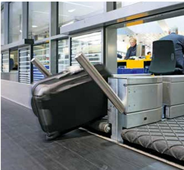
Belt pengumpul di area check-in bandara. Kerataan jenis belt ini memastikan bahwa barang dapat dibongkar ke samping dengan lancar, bahkan pada belt yang lebar.
